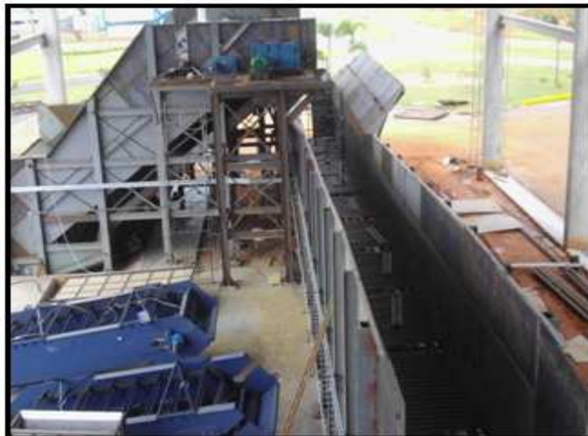
Fonte: http://www.romestec.com.br/imagens/uploads/produto (2014). FIGURA 7 – Esteira metálica alimentação de cana picada/inteira.
